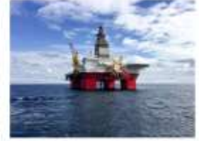
Petrol, gaz ve minerallerin denizden çıkarılması
