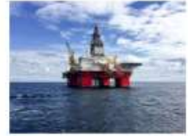
Petrol, gaz ve minerallerin denizden çıkarılması
