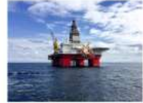
Petrol, gaz ve minerallerin denizden çıkarılması
